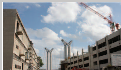
Début en 2007 des travaux du projet d’aménagement de 85 million d’euro.
